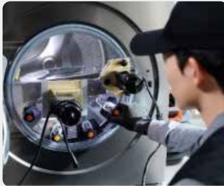
분해 없는 초음파 세척 장비 설치
